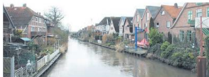
Und darum geht es: Eine Deicherhöhung käme hier dem erzwungenen Abriss der Häuser gleich
